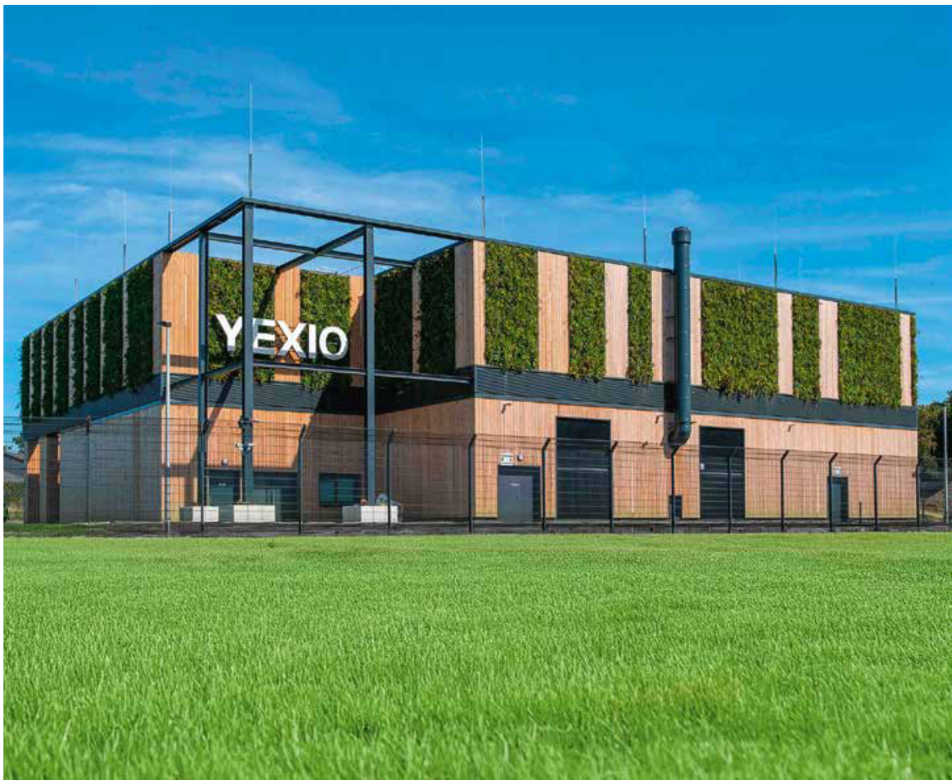
Das Yexio-Rechenzentrum im Innovationspark Heiligenhaus wurde in Massivholzbauweise errichtet und sparte so 600 t CO 2 gegenüber einer konventionellen Bauweise.
