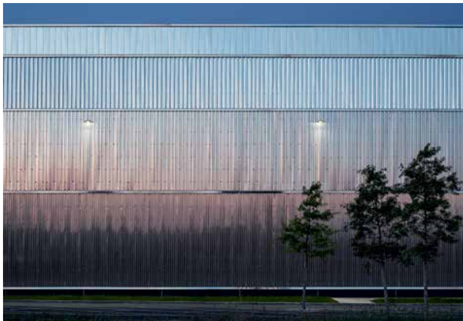
Als klassisches Fassadenthema ist die Edelstahlfassade in vier horizontale Ebenen unterteilt.
