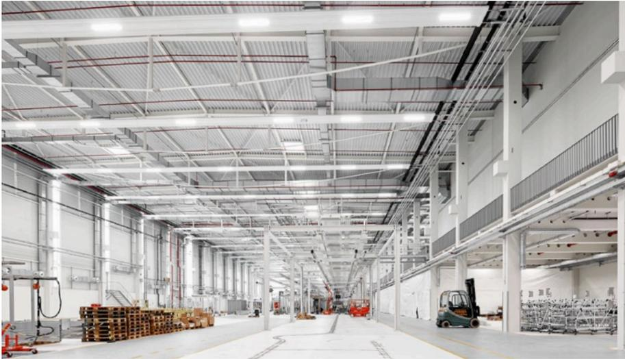
Mittig ist mittlerweile die Produktionslinie errichtet, die graue Bodenbeschichtung links und rechts zeigt bereits die Durchgänge durch die Halle an.
