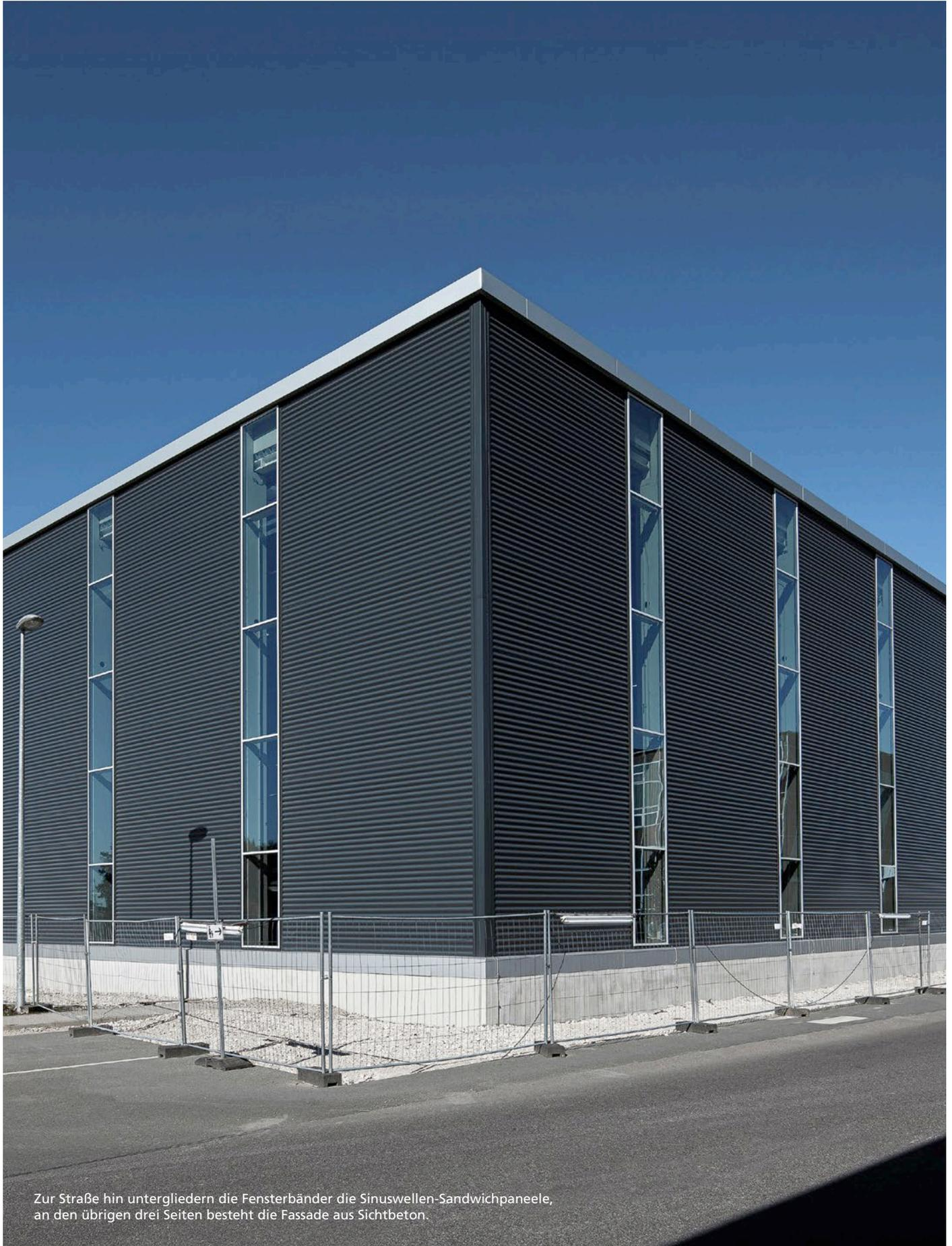
Zur Straße hin untergliedern die Fensterbänder die Sinuswellen-Sandwichpaneele, an den übrigen drei Seiten besteht die Fassade aus Sichtbeton.
