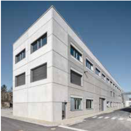
Der Werkstatt- und Laborbau bildet die Verlängerung der Produktionshalle.
