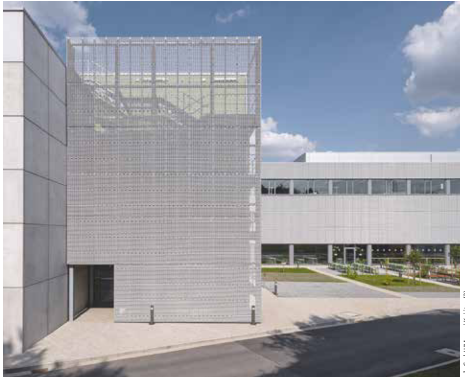
Verbindungsbau mit Streckmetallfassade.
