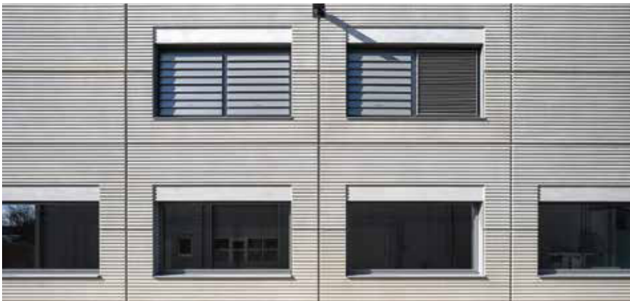
In die Schalung der Stahlbetonfertigteile wurden profilierte Matrizen eingelegt. Das betont die einzelnen Elemente und macht den Herstellungsprozess sichtbar.
